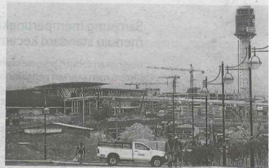
Kerja-kerja pembinaan KLIA 2 di Sepang giat dijalankan.
